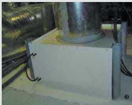
Système de serrage des filtres THE (grenouillère)
