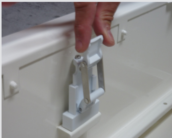
Système de serrage des filtres THE (grenouillère)
